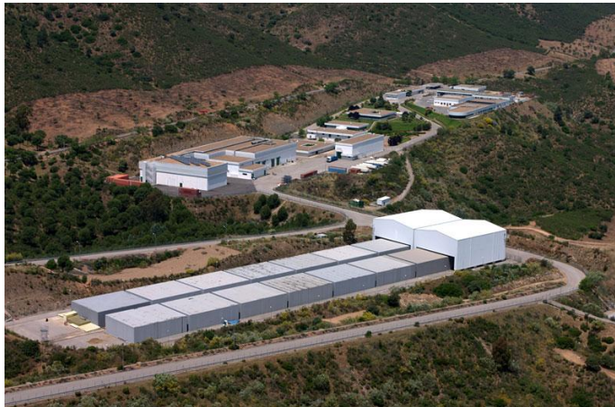
Instalaciones de El Cabril (CÓRDOBA)
